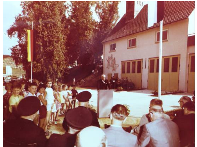
Abbildung 4: Einweihung des neu erstellten Feuerwehrgerätehauses am 06.07.1963
