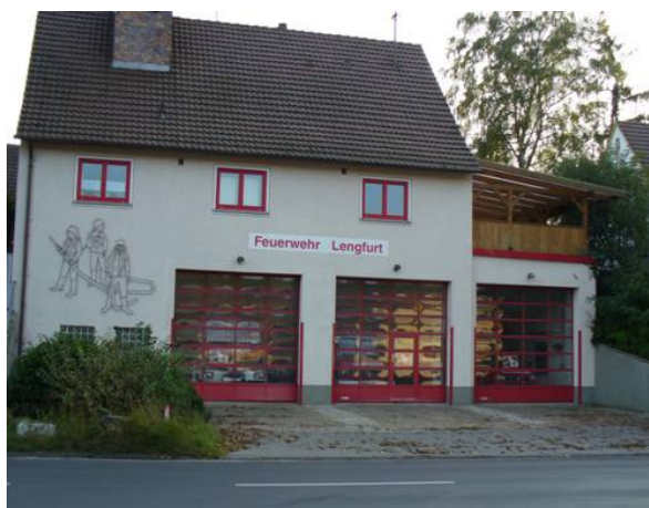
Abbildung 20: Außenansicht des Gerätehauses
